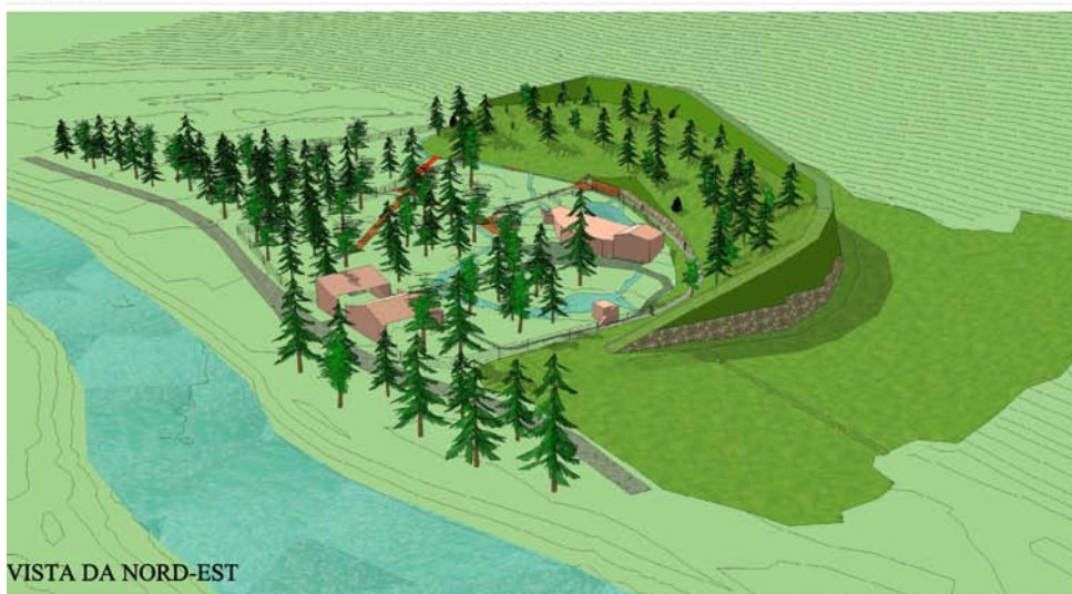
Fig. 74 - Il Centro per la tutela dei corsi d'acqua protetto da vallo paramassi in una simulazione a termine lavori. Foto M. Fiou
