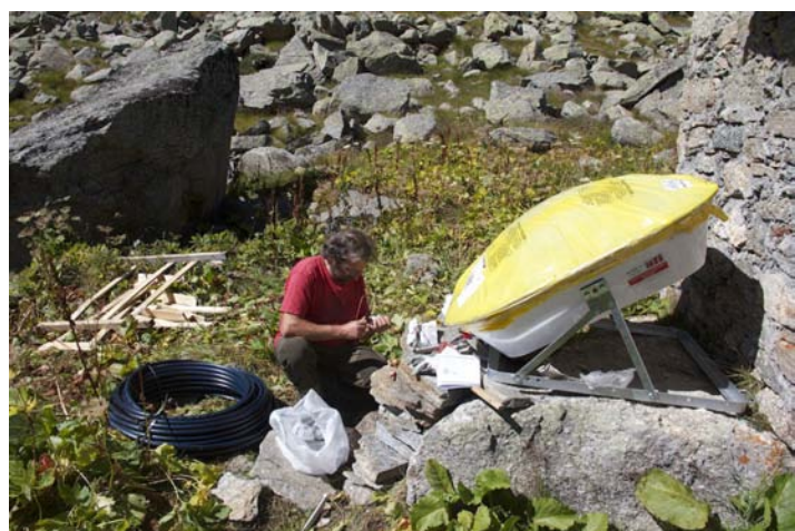
Fig. 94 - Uno dei lavori di realizzazione di impianto solare termico per fornire di acqua calda i casotti. Foto Archivio PNGP
