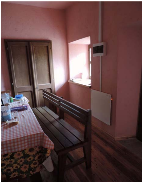
Fig. 88 - Presso il Gran Piano l'operatore specializzato del Parco ha rifatto il pavimento in legno e installato resistenza zavorra e 2 stufette, oltre a diversi altri lavori sull'impianto elettrico. Foto D. Carnicella
