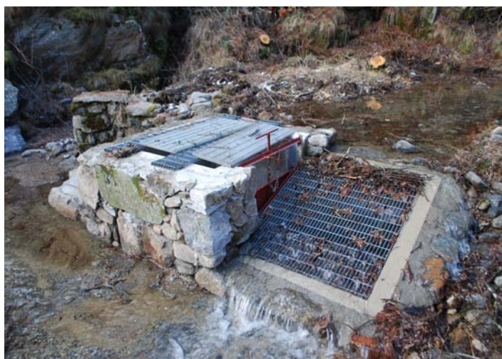
Fig. 73 - Altri lavori accessori: verifica della vasca di captazione, scavi per la realizzazione dell'impianto di irrigazione, allaccio del troppo pieno. Foto B. Rosai
