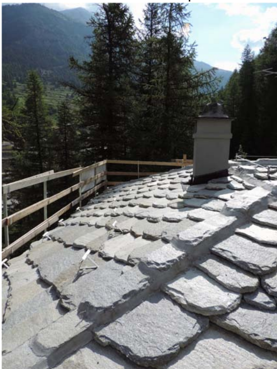
Fig. 91 - Il tetto della "Villetta" a lavori terminati. Foto B. Rosai
