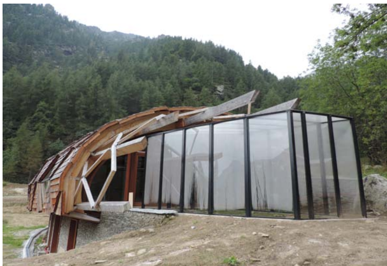
Fig. 70 – Tra i lavori 2015 presso il Centro “L'Uomo ed i coltivi” vi sono le fondazioni e la posa della serra. Foto B. Rosai
