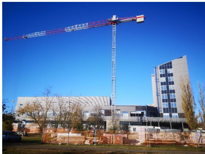
Figura 9 – Immagine del cantiere di realizzazione del nuovo Edificio 1 della Food Project Area
