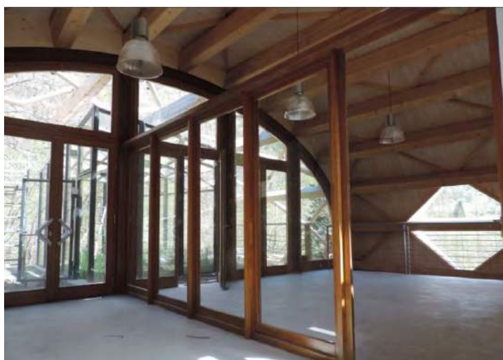
Fig.7-5 - La parte di fabbricato che aggetta sulle serre esterne. Foto B. Rosai
