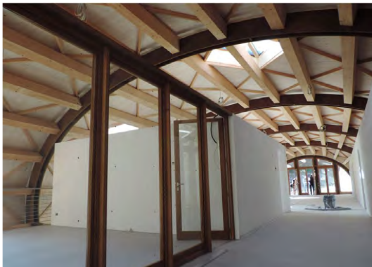
Fig.7-4 -L'interno della zona centrale del fabbricato. Foto B. Rosai
