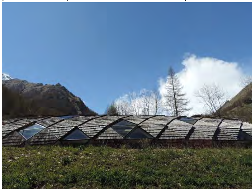
Fig.7-3 - Un particolare del tetto ad embrici di scandole del fabbricato. Foto B. Rosai
