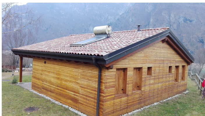
Edificio interessato dai lavori di riverniciatura in valle del Mis
